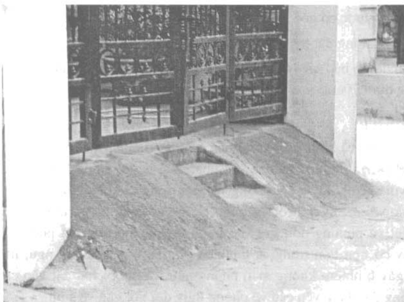
Hình 4.13. Nền sân nhà đặt quá cao so với mặt đường
