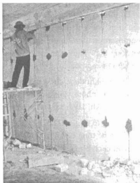
Hình 5.2. Sản phẩm Bloc và tấm tường lắp nhanh từ bê tông Polystyrene [67]
