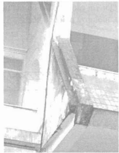
Hình 5.19. Kết cấu bị rêu mốc do tích ẩm nước tưới cây và tích bụi lâu ngày trên mặt kết cấu
