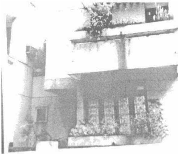
Hình 5.19. Kết cấu bị rêu mốc do tích ẩm nước tưới cây và tích bụi lâu ngày trên mặt kết cấu
